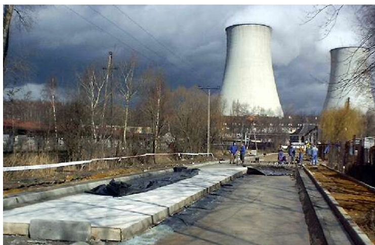
Rys.5 Widok fragmentu lokalnej drogi o nawierzchni betonowej wykonanej z dodatkiem Flubet-B na terenie Elektrowni Turów
