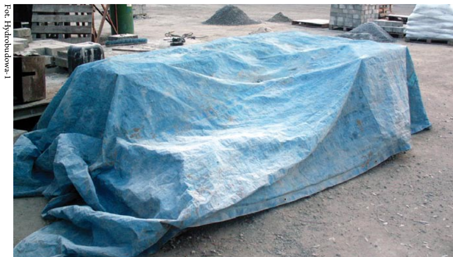
↑ Fot. 1. Elementy na umocnienie brzegów rzek po zabetonowaniu (temperatura średnia 0 stopni C).
